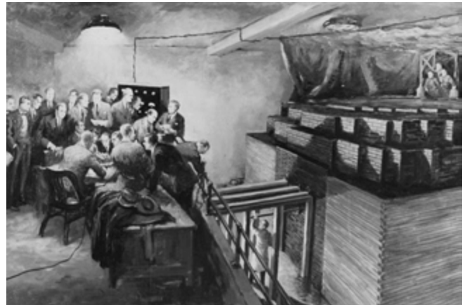
CP-1, primer reactor artificial de fisión nuclear construido por Enrico Fermi y sus colegas con bloques de grafito, como moderador, y uranio natural como combustible. https://es.wikipedia.org/wiki/Chicago_Pile-1
